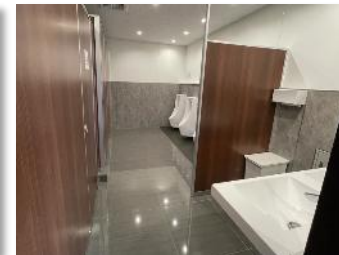
インフラ改修
