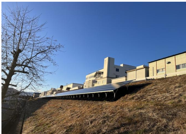
太陽光パネル設置状況
